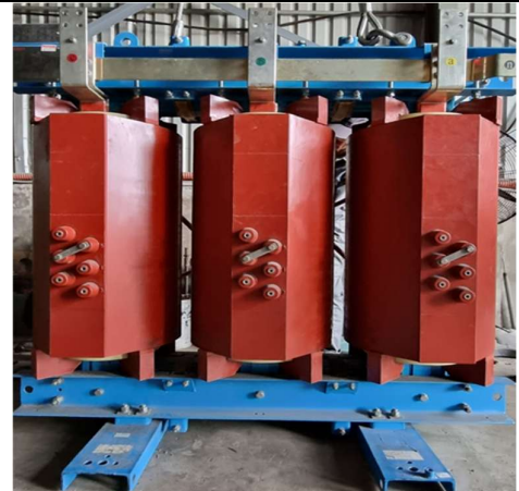
SỬA CHỮA MÁY BIẾN ÁP KHÔ 2000KVA – 22/0,4KV REPAIR OF DRY TRANSFORMER 2000KVA – 22/0.4KV
