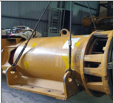
SỬA CHỮA MÁY PHÁT 1000KVA – 0.4KV REPAIR OF 1000KVA – 0.4KV GENERATOR
