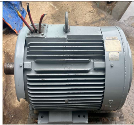
SỬA CHỮA ĐỘNG CƠ ĐIỆN 250KW-6.6KV REPAIR OF 250KW-6.6KV ELECTRIC MOTORS
